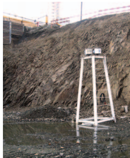
Рис. 2. Вид строительного котлована под проектируемую башню «Исеть»
